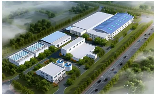
山钢日照海水淡化工程
