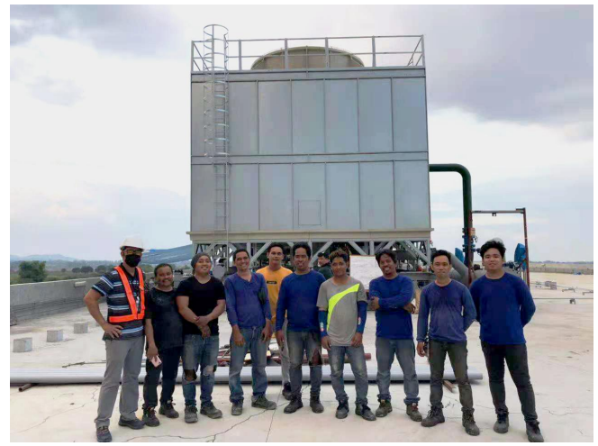
克拉克机场项目 CLARK INTERNATIONAL AIRPORT PROJECT
