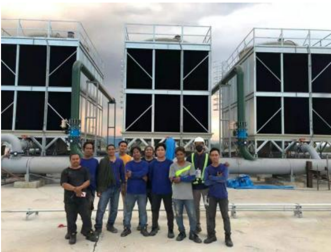
NST-Z7系列冷却塔 NST-Z7-700-1 x 3
