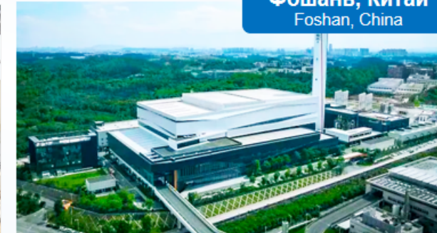
УСТАНОВКА ПО ПРОИЗВОДСТВУ ВОДОРОДА GREEN HYDROGEN PRODUCTION INDUSTRY
