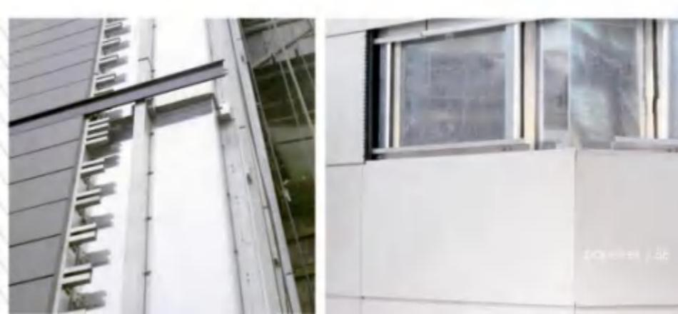
伯陶科采用最新的技术设计了独特的干挂构件系统。陶瓷面板的安装使用不锈钢龙骨去完成。
